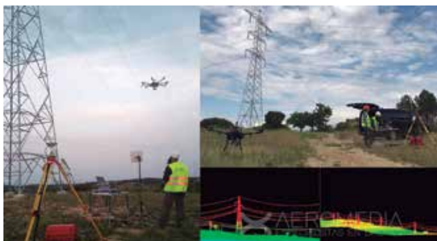
Figura 11. Trabajos realizados en Líneas Eléctricas Aéreas con sistema LiDAR+RPAs (Fuente: AEROMEDIA UAV)
