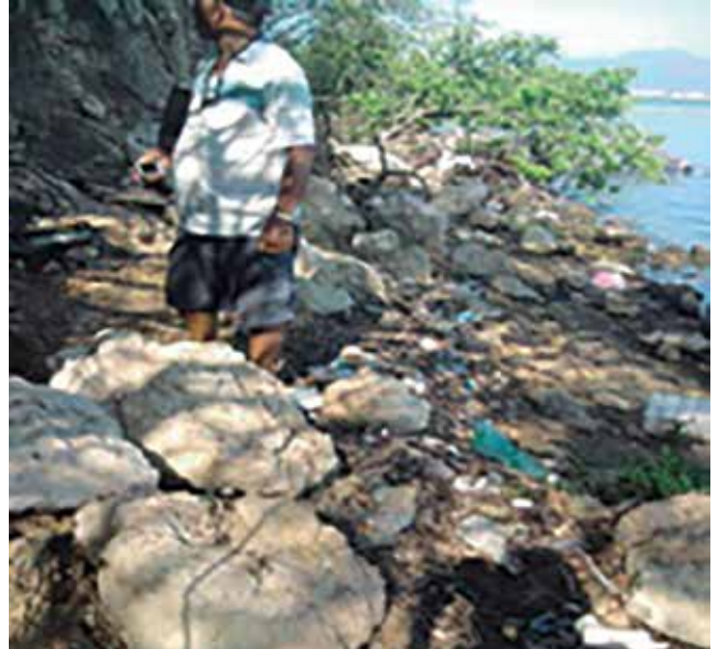
Figura 8. Rocas desprendidas en la costa este de la bahía de Santiago de Cuba
