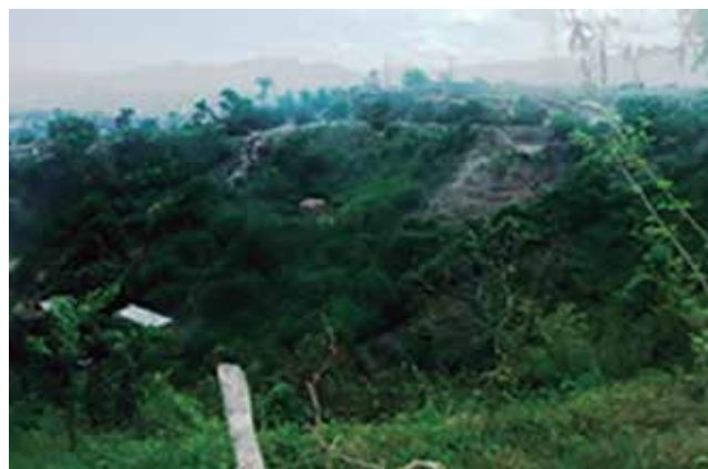
Figura 5. Sobrecarga a las laderas naturales (al fondo zona de basurero en la ladera)
