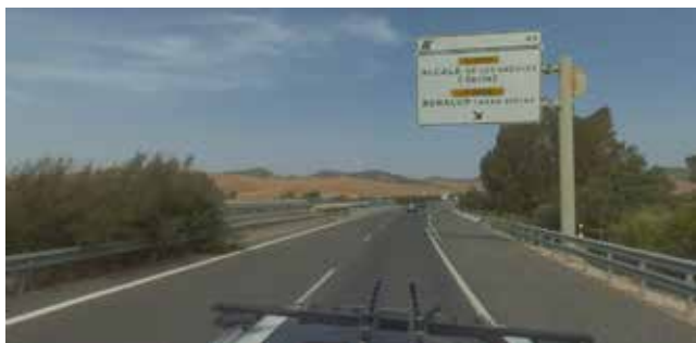
Figura 9. Señal vertical de tipo cartel sobre banderola, sistemas de contención de tipo barrera metálica simple tanto con una como con dos alineaciones y pretiles, ejemplos de activos inventariados en la carretera A-381 de Cádiz
