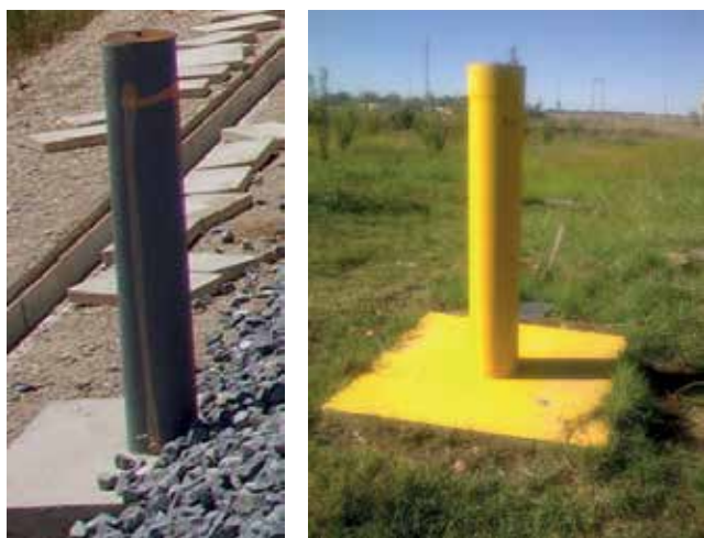
Figura 4. Imagen izquierda: vértices utilizados para materialización de superestructura. Imagen derecha: hitos kilométricos.
