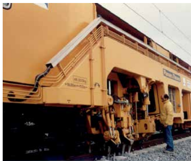
Figura 6. Máquina bateadora en pleno trabajo. LAV Madrid-Sevilla.
