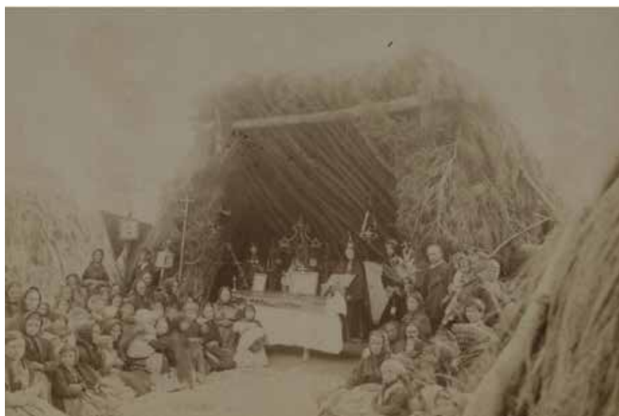
Iglesia provisional de Jatar tras el terremoto de 1884, fotografía realizada por la Comisión francesa presidida por Ferdinand André Fouqué.
