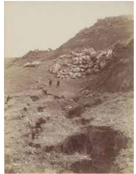
Grietas junto al pueblo granadino de Güevejar (Comisión francesa presidida por Ferdinand André Fouqué)
