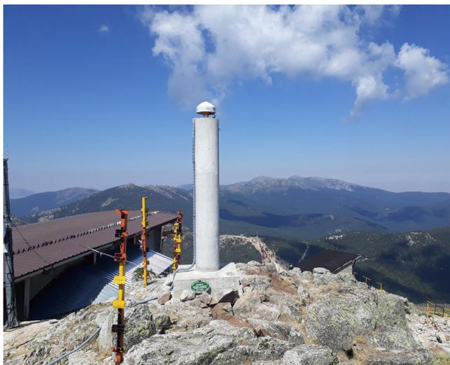
Figura 2. Estación permanente GNSS en el Puerto de Navacerrada
