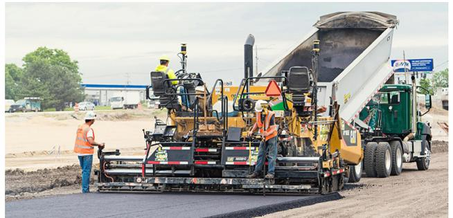
Figura 12. Asfaltado con sensores GNSS (imagen cortesía de Topcon)
