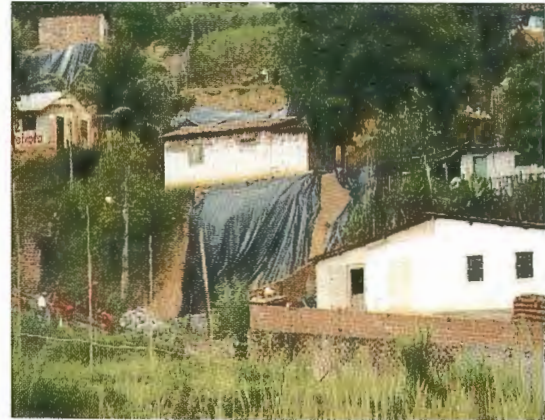
Fig. 1. Área de riesgo geológico.
