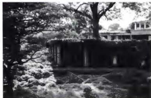
Aspecto de la entrada principal del Hotel Casino de la Selva poco antes de ser derribado
