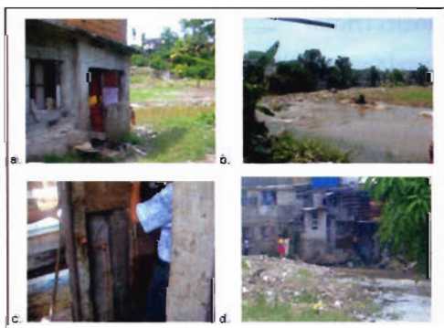
Figura 10. Daños ocasionados por la inundación en el Hoyo de la Lisa; a. Vivienda situada a 5 metros del lecho del río y donde el agua llegó a una altura de 0.95 metros, b. Río Quibú, c. Vivienda de madera en muy mal estado, d. Viviendas situadas en el plano de inundación del río Quibú. Tomadas por Eugenio Landeiro y Teresa Imbert, et al. Fecha 24 de mayo del 2006.
