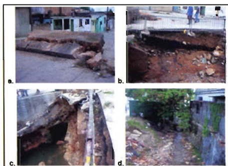
Figura 14. a., b. y c. Muro de contención destruido, evidencia la capacidad de arrastre de la crecida de la corriente del Río. c. Al fondo casa mal situada sobre el río Quibú.
