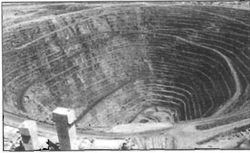
(Izquierda) La mina de cobre Palabora, a 360 kms de Pretoria, África. Las extracciones subterráneas en una galería de 1 km han producido inestabilidades dramáticas: más de 60 millones de Tm cayeron al fondo desde la pared norte, con hundimiento del terreno hasta 2 m en el borde superior del pozo cónico. La empresa AMEC ha recurrido en 2006 a ESA para usar el InSAR del Envisat con el fin de detectar subsidencias inferiores al centímetro. Se trata de vigilar una zona amplia, no solo el pozo minero. El satélite es más económico que los sistemas tradicionales terrestres. (Centro) La subsidencia en la ciudad de Bolonia, observada por la interferometría diferencial del ERS. Se han codificado los colores para mostrar el grado de subsidencia. La ciudad se halla entre los ríos Reno y Savena, con agua subterránea en el subsuelo. (Derecha) Interferograma de Bam, Pakistán, cuando recientemente sufrió un potente terremoto, observado por el InSAR de Envisat
