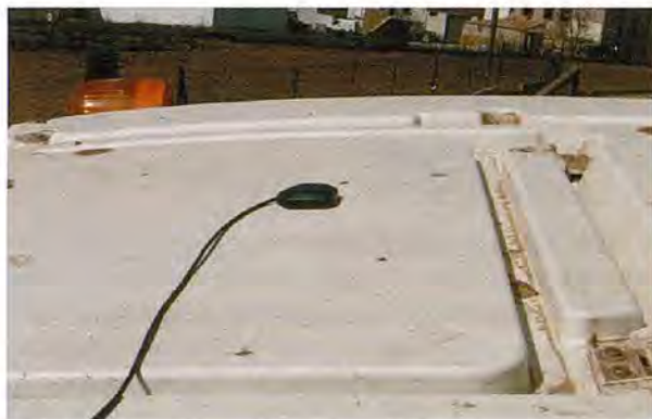
Figura 16: Antena GPS situada en la parte superior externa de la cabina
