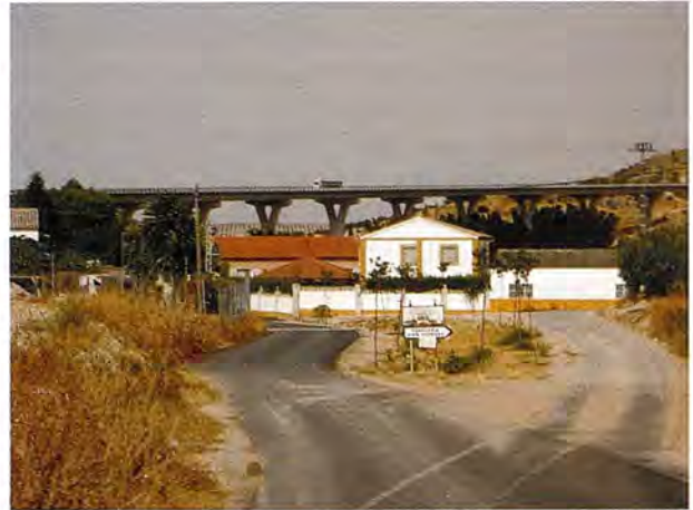
Figura 2. Vista general del viaducto y la zona.
