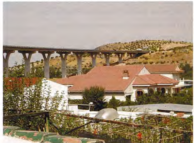
Figura 3. Vista de las viviendas afectadas.
