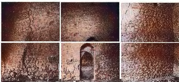
Figura 2. Planificación de los puntos de control
