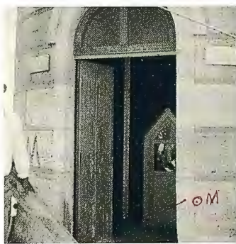
FIGURA 07 - Fotografia do marégrafo indicando a marca de contacto do poço do marégrafo (1940).
