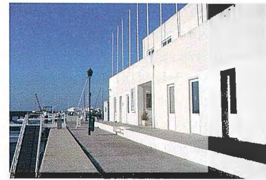
FIGURA 31 - Edifício da Marina de Cascais que alberga o Marégrafo Acústico Digital
