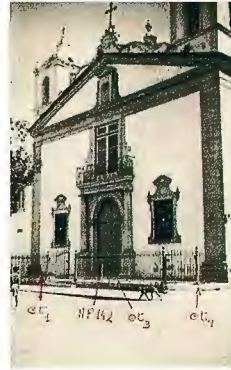
FIGURAS 10 e 11 - Marcas NP 142 e testemunhas t1, t2, t3 e t4. A NP 142 está chumbada na soleira da porta da Igreja de Santa Maria, em Lagos, junto da ombreira do lado do Evangelho. 1950 - Obras de remodelação do pontão onde se encontra o marégrafo, com a destruição da antiga casa-abrigo e construção da actual. Alteração da localização do marégrafo.
