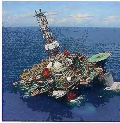
Plataforma destruida por el paso de un ciclón tropical
