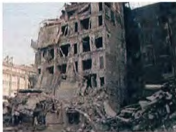
destrucción parcial y hasta total
