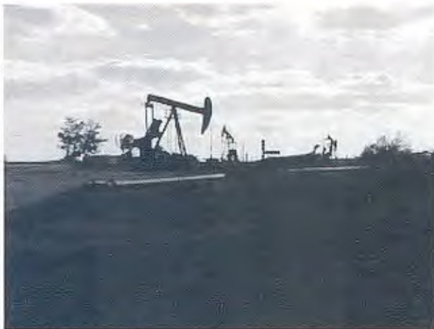
Fig. No 3 Pozos de extracción en Boca de Jaruco
