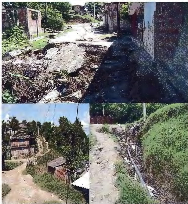
Fig.2 Imágenes de la localidad de Altamira, Barriada situada en la periferia de la ciudad de Santiago de Cuba, lugar donde se observa con claridad el riesgo a deslizamiento. Noviembre 2008
