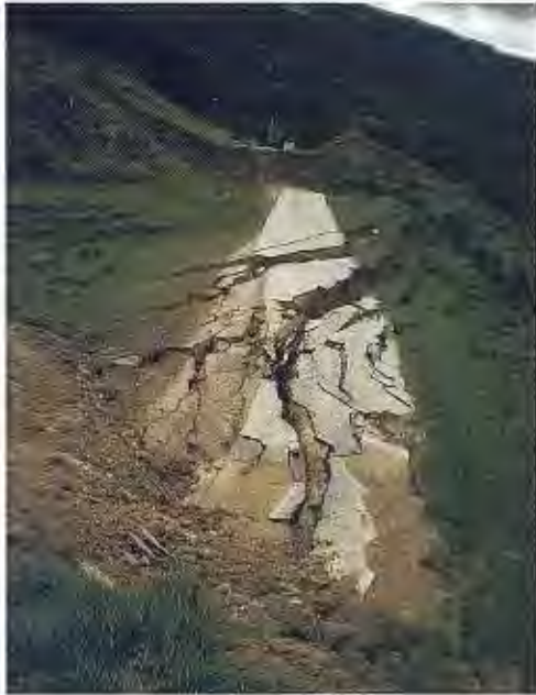
Fotos 1. Deslizamiento del tramo de la carretera de la Güira a Boquerón.
