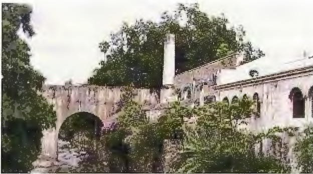
Imagen 6. Ex-Hacienda de Real del Puente, al fondo el Acueducto y el río Apatlaco, hoy Hotel (5 estrellas)
