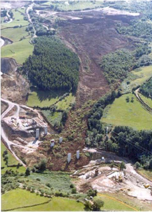
Figura 3: Vista aérea del deslizamiento del vertedero y las pilas semienterradas
