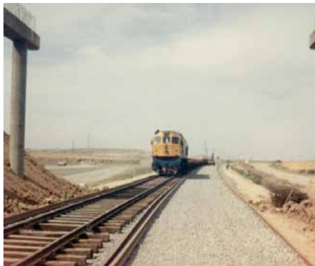
Figura 5. "Tren carrilero" circulando sobre vía auxiliar. LAV Madrid-Sevilla.
