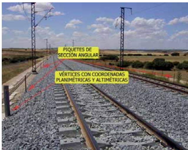
Figura 12. Piquetes y vértices. LAV Madrid-Valencia Gabaldón Cuenta Siete Aguas Valencia
