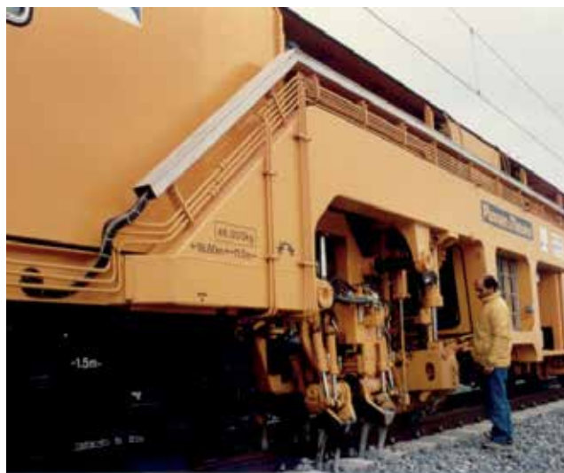
Figura 6. Máquina bateadora en pleno trabajo. LAV Madrid-Sevilla.
