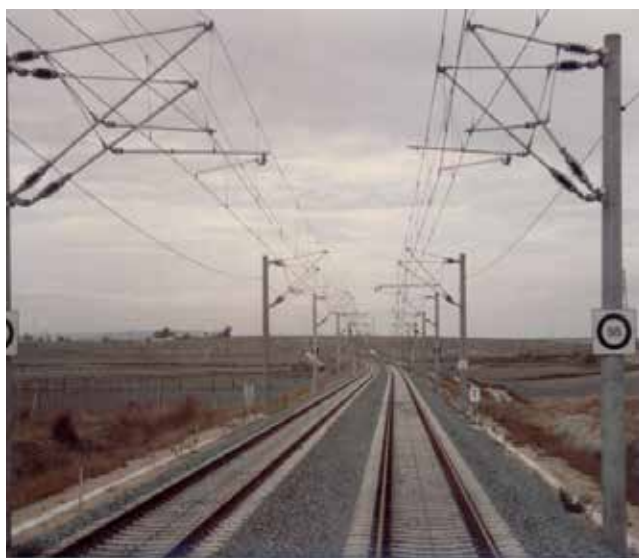
Figura 7. Aspecto de la línea terminada, con toda la infraestructura viaria. LAV Madrid-Sevilla.
