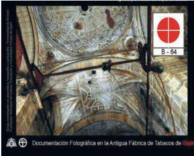
Figura 14. Vista parcial del interior de la iglesia (después almacén de hoja tabaco) y diana de control métrico. de la RCM.
