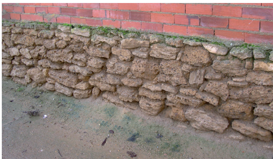
Figura 16. Reutilización de piedras procedentes de la cimentación de una calzada de Tierra de Campos en la cimentación de un edificio de reciente construcción (Cerecinos de Campos, Zamora).
