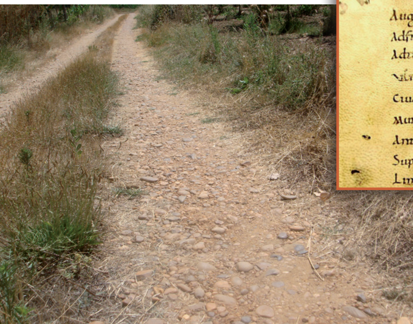
Figura 4. Tramo de calzada cimentado exclusivamente con cantos rodados (Milles de la Polvorosa)
