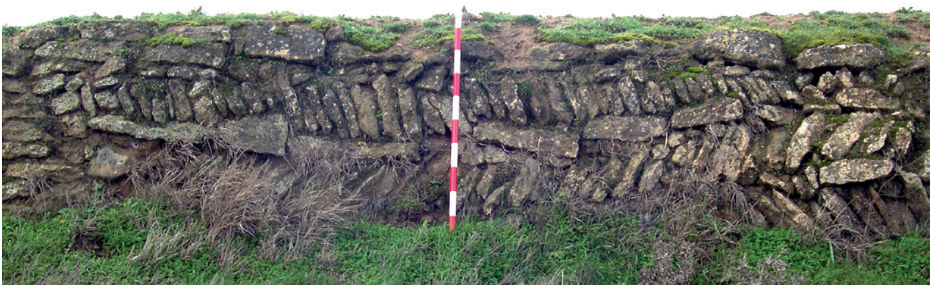
Figura 2. Restos de calzada en San Esteban del Molar (Zamora), localizados por el autor a principios de 2010. Se aprecian nítidamente las hiladas de piedras de canto del rudus, tal y como se describen por Grenier
