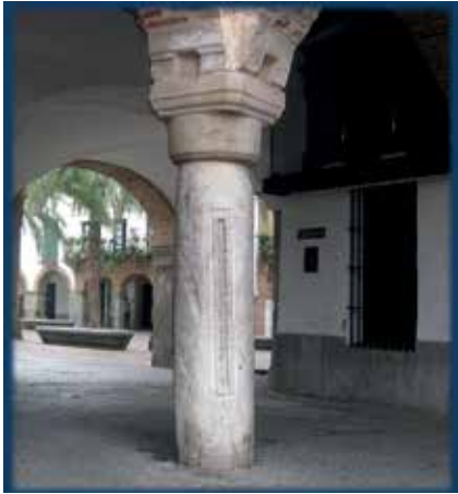
Figura 2. Prototipo de la «vara de medir» en un pilar de la Plaza Chica de Zafra (Badajoz). La vara era para el padre Mariana la fuente u origen de las demás medidas de España
