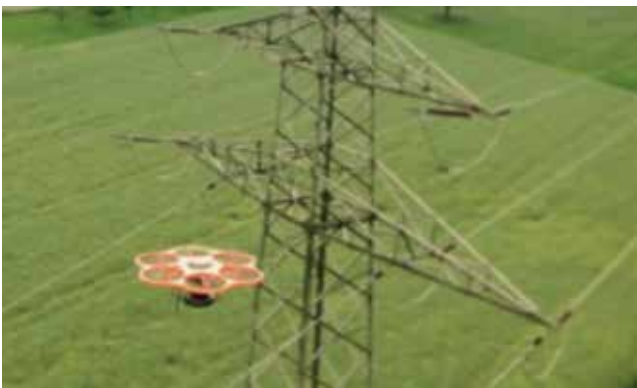
Inspección de líneas eléctricas
