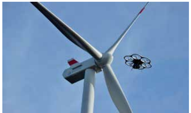
Inspección de molinos de vientos
