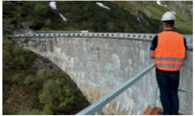
Inspección de presas
