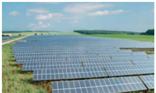
Inspección de sistemas solares
