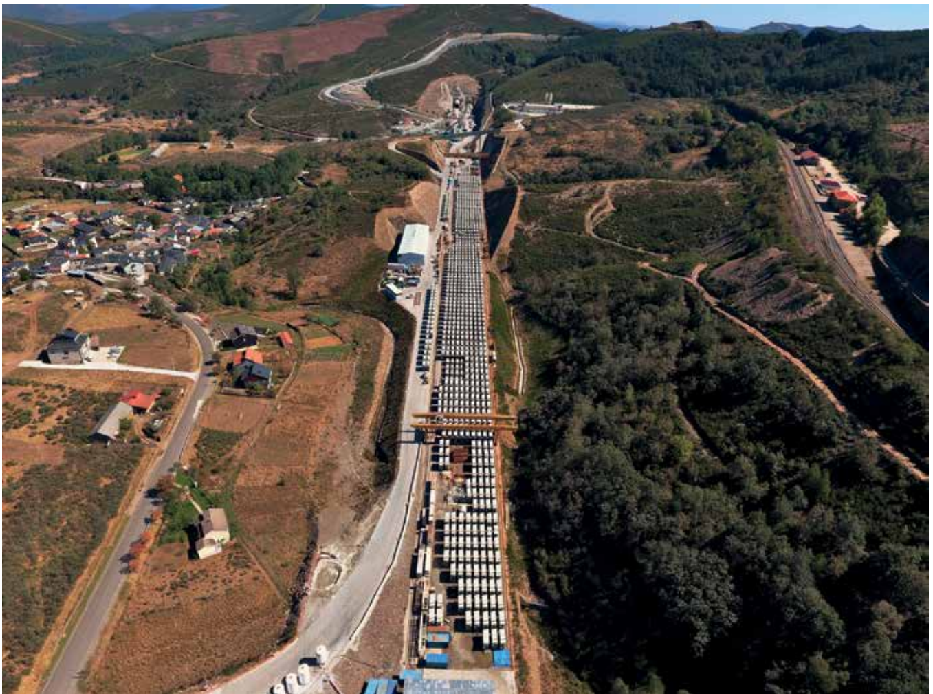
Figura 1. Imagen panorámica de implantación de obra
