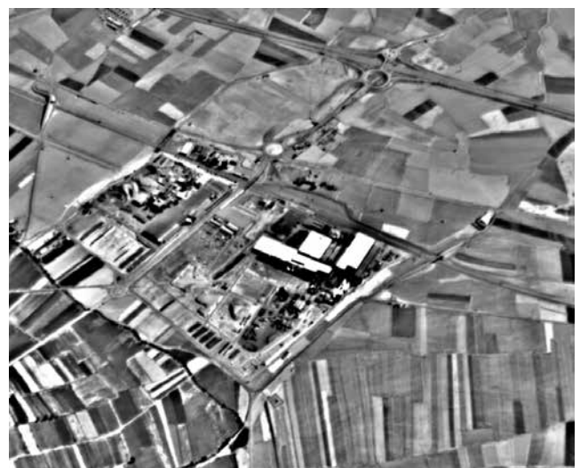
Figura 2. Imagen IR de una instalación industrial
