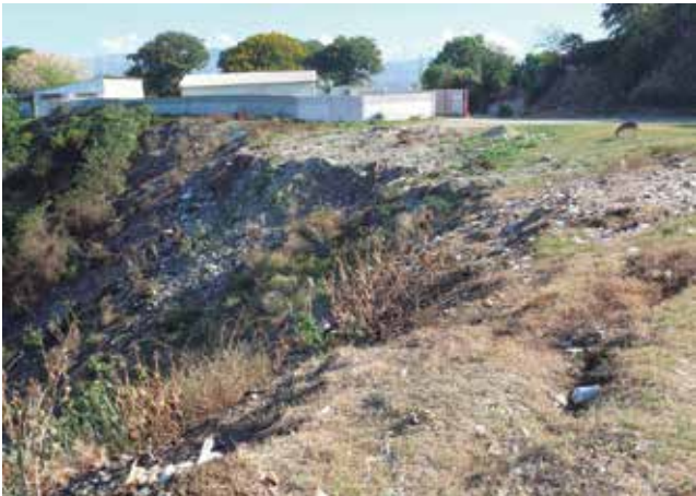
Figura 9. Talud ubicado en zona de moderada susceptibilidad a los deslizamientos ubicado detrás del motel Bella Vista, donde depositan basura y escombros que provocan la sobrecarga estática del talud
