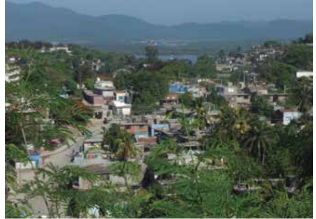
Figura 3. Barrios y asentamientos, construidos en las laderas al este de la bahía de Santiago de Cuba, con la construcción de senderos peatonales sin estudios técnicos y sin obras de protección y drenajes adecuados. Reparto Van Van, Consejo Popular Altamira, Santiago de Cuba
