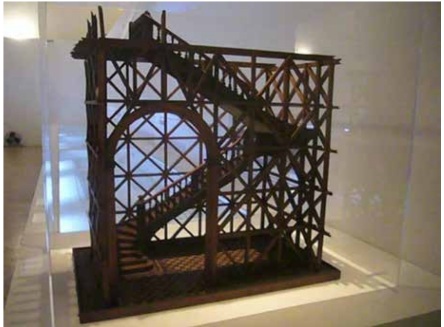
Modelo de Gaiola pombalina (Jaula pombalina), una estructura arquitectónica de madera resistente a los terremotos, desarrollada en Portugal en el siglo XVIII para la reconstrucción del centro pombalino de Lisboa, tras el devastador terremoto de Lisboa de 1755.
