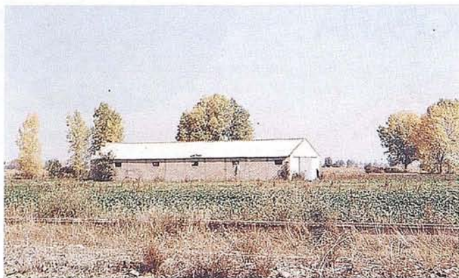
Nave agrícola sobre paisaje "mosaico de cultivos de regadío". Grado de adecuación inadmisible .
