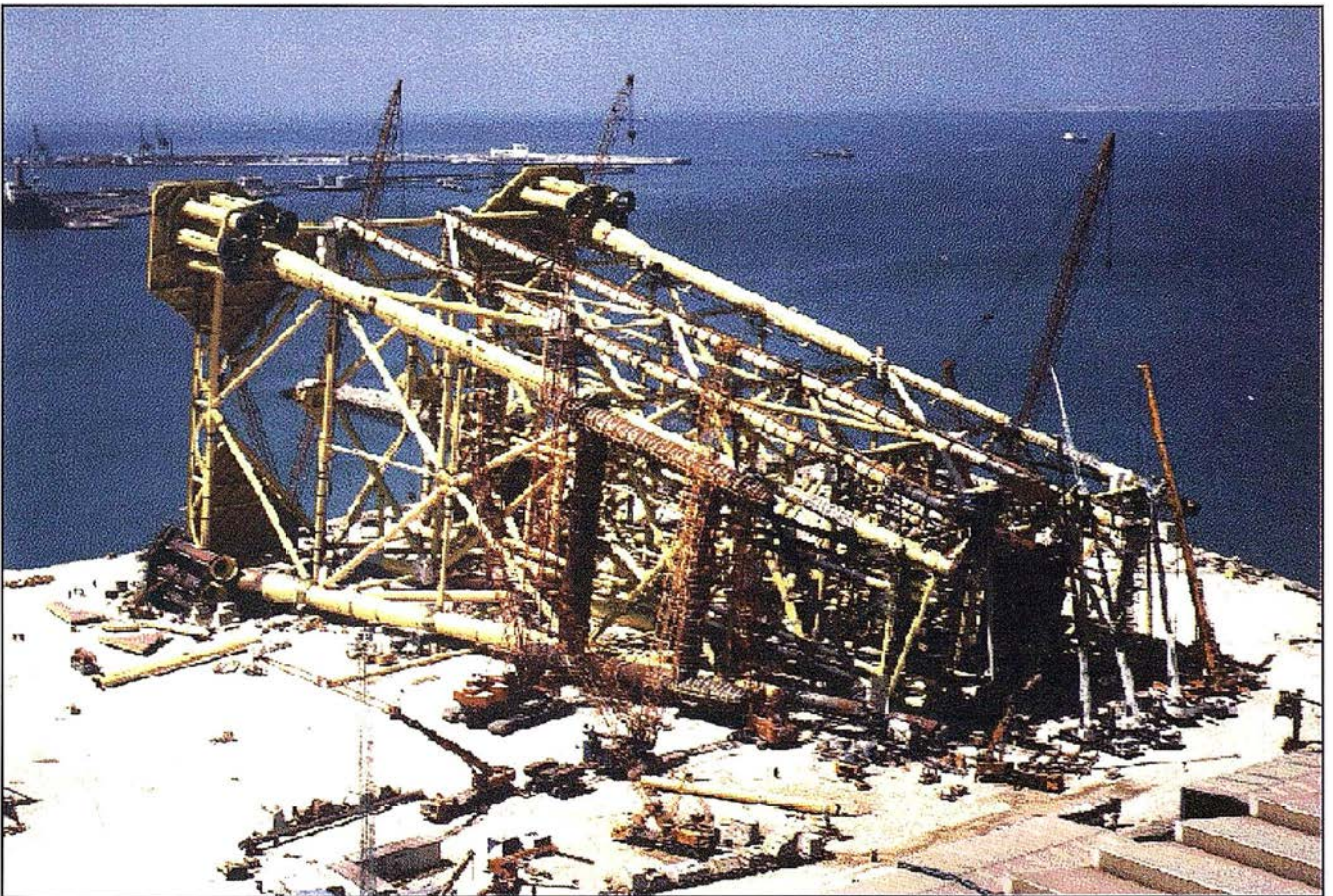
Jacket Britannia de espectaculares dimensiones – Precisiones en Control Dimensional milimétricas para 20.000 toneladas de acero.
