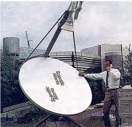
Estación terrena transportable para servicios telefónicos de Intelsat. Al fondo la sede. (Foto INTELSAT)
