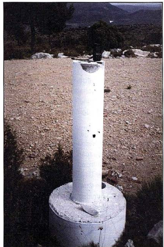
Figura 19. 2724 - Vértice Mirador, Alpuente (Valencia). 638/3.3/03. Parcialmente destruido por la parte de arriba, se conserva el clavo y el centrado forzoso.
