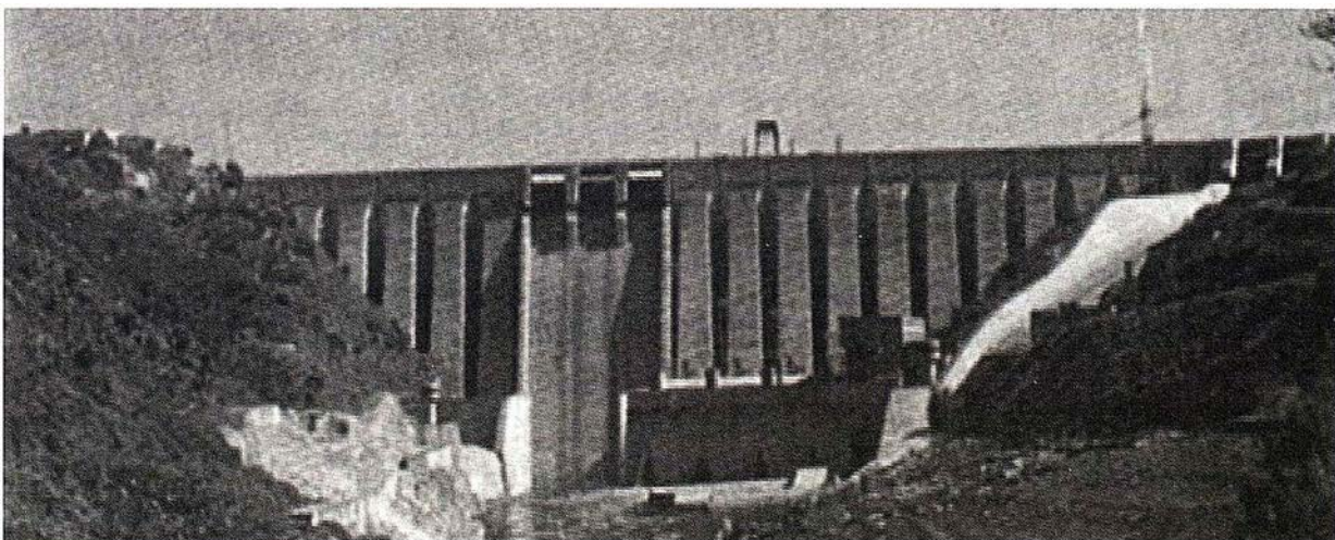
Fig. 3: Presa de contrafuertes.
