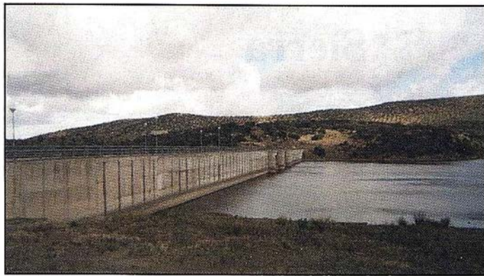
Fig. 12: Presa de Nogales.
